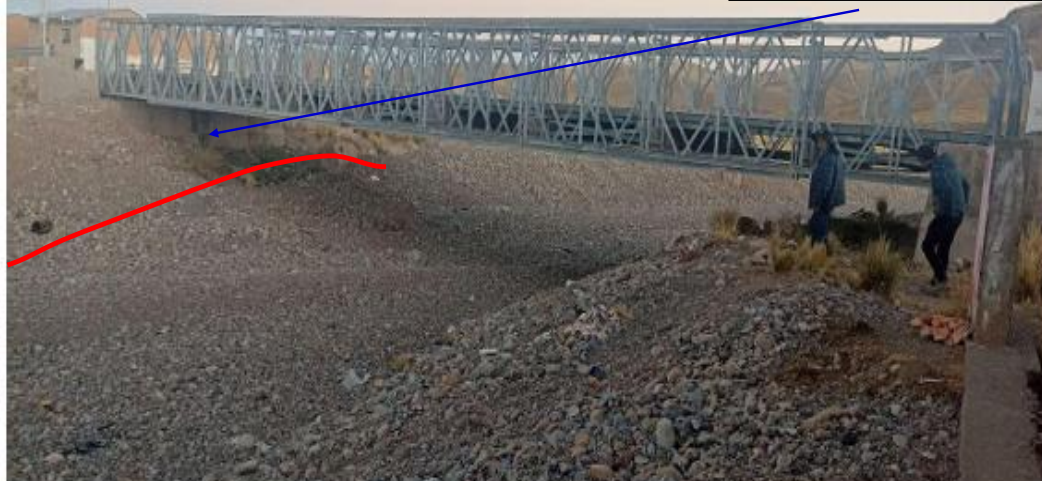
FIGURA N°02: ZONAS PROPENSAS ANTE UNA CRECIDA DEL RÍO AÑUCAYA Y LA EROSION FLUVIAL EN LA MARGEN DERECHA, PUENTE CARROZABLES EXPUESTOS ASI COMO VIVIENDAS.
